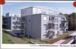
modulares MEHRFAMILIENHAUS | Morlauterer Straße
